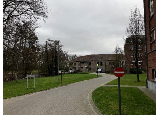
Foto 12: Zicht op gebouwcluster
